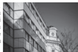
Detail Alfa s bývalým poštovním úřadem s hodinami, které se zastavily ještě před revolucí
